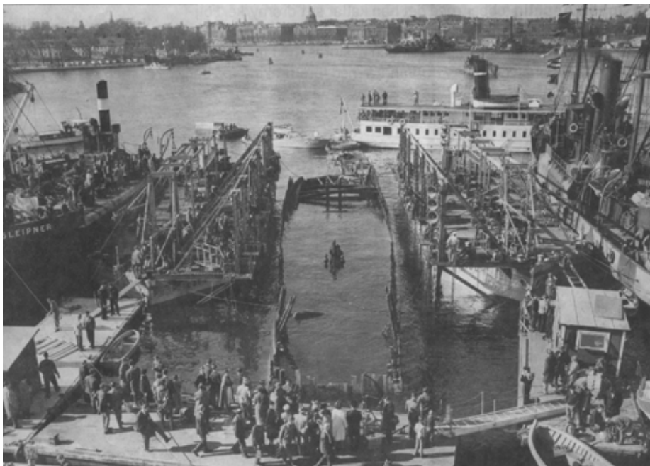
► Genom lyckosamma bärgningar blir olyckor stolta nationsprojekt. Bärgningen av Vasa (1961).
